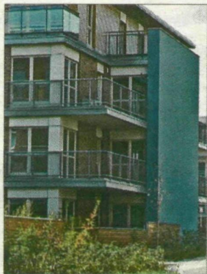
♦ Dębowe Tarasy w Katowicach
