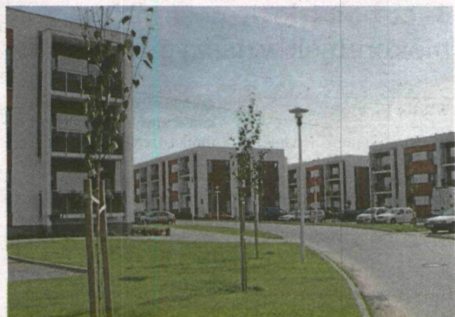
Na Osiedlu Kalinowym system kontenerów jest pod ziemią
