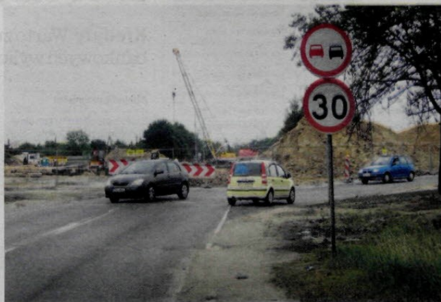
Remontowana ulica Bukowska w Poznaniu
